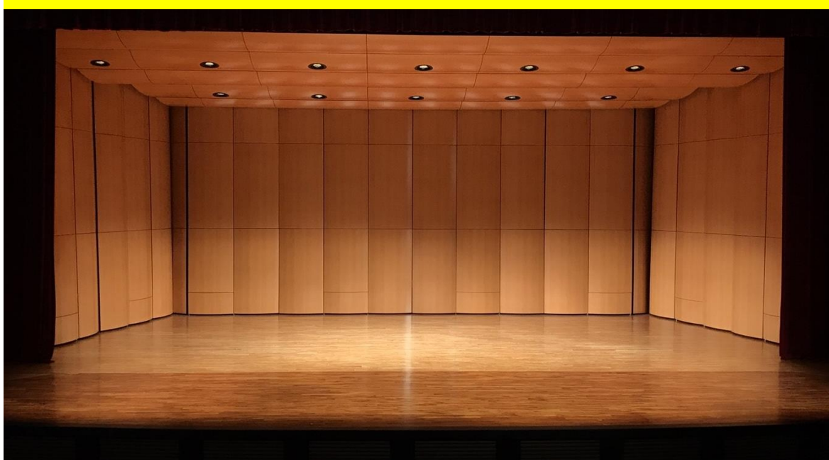
音響反射板組合示意圖
